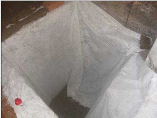
FOTO 11. Cobriment amb geotèxtil del sondeig 4.
